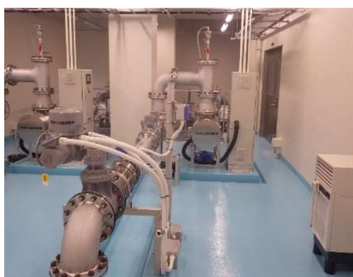
鷹巣浄水場 紫外線処理装置
